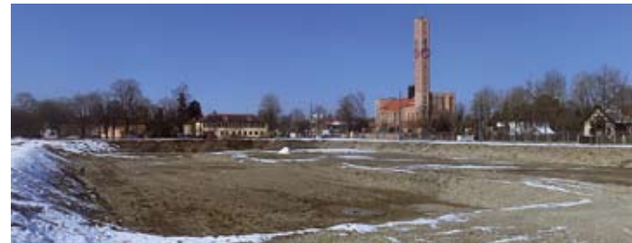
Die riesige Baugrube lässt Böses ahnen
