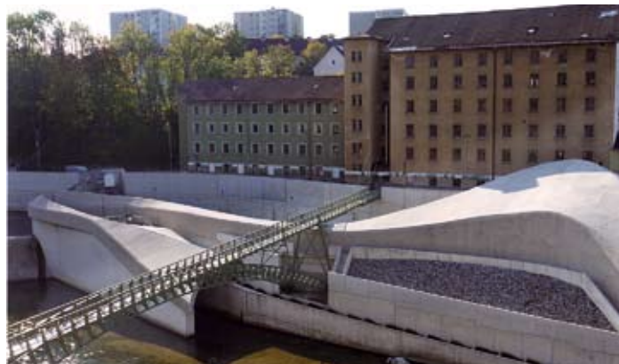
Neues Illerkraftwerk an der Keselstraße
