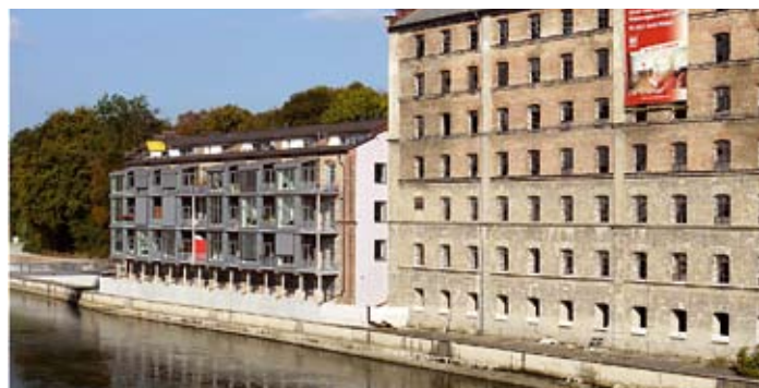
Nutzung der ehemaligen Spinnerei und Webereigebäude als Wohnraum in der Rosenau
